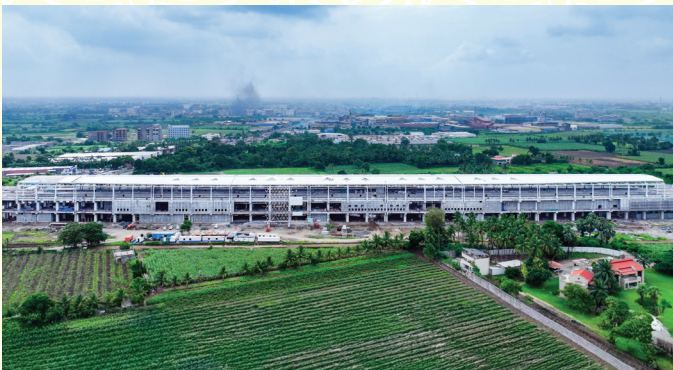
निर्माणाधीन सूरत बुलेट ट्रेन स्टेशन
