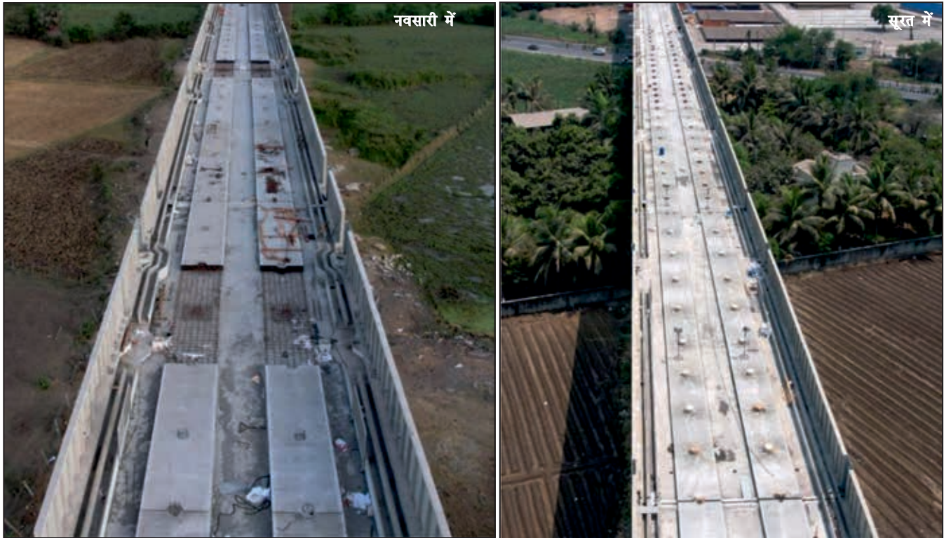
गुजरात नवसारी में ट्रैक कार्य प्रगति पर
