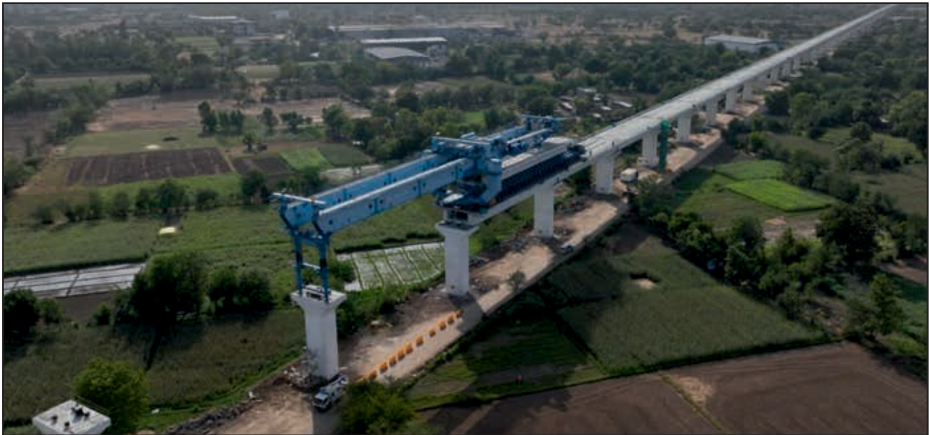
संचालन में पूर्ण अवधि लॉन्चिंग गैन्ट्री, अहमदाबाद जिला, गुजरात
