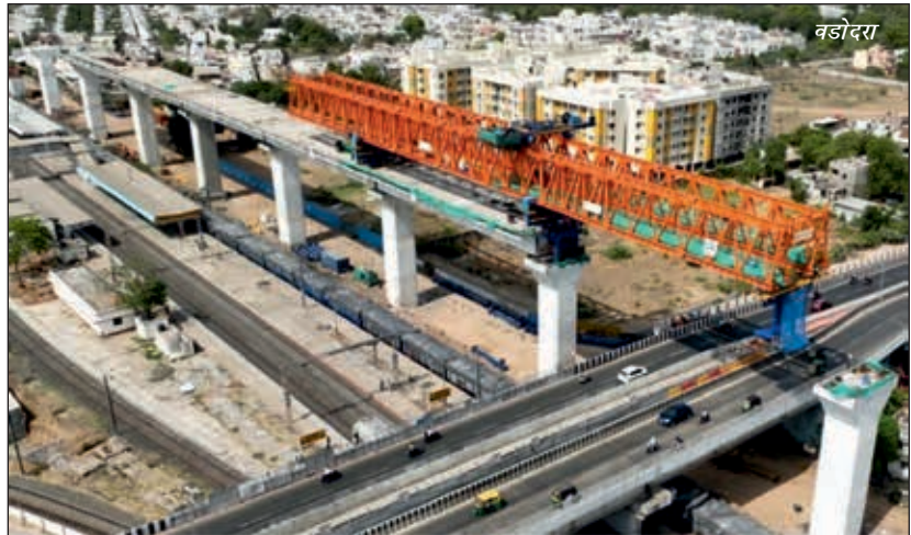
गुजरात में सेगमेंटल लॉन्चिंग गैन्ट्री का संचालन
