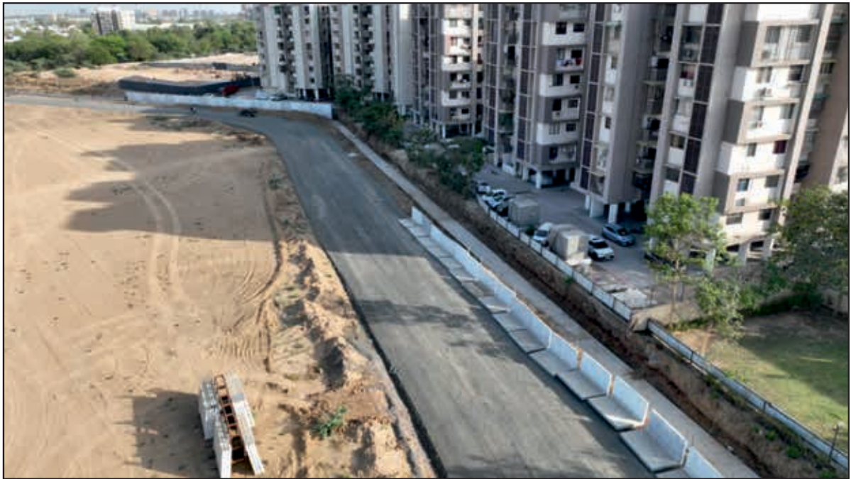
सड़क कार्य एवं प्रीकास्ट रिटेंनिंग वॉल निर्माण कार्य, साबरमती डिपो, गुजरात
