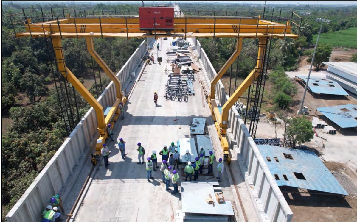
शोर अवरोधक निर्माण कार्य प्रगति पर, नवसारी, गुजरात
