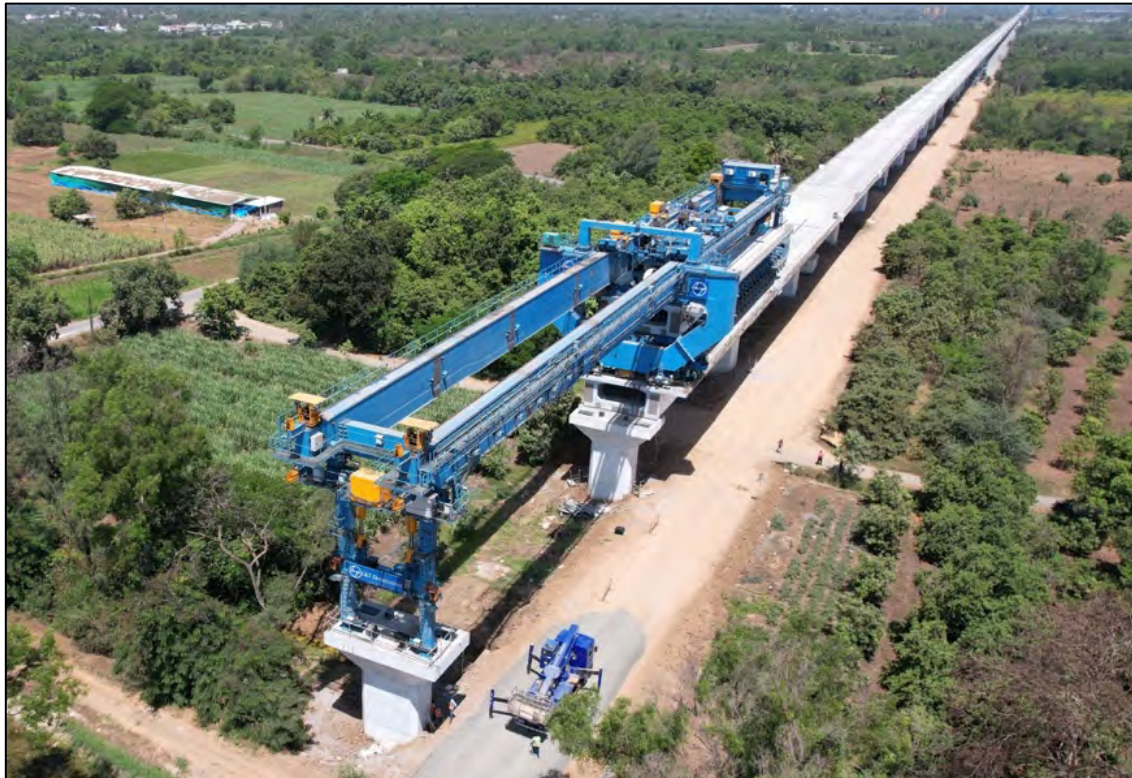
नवसारी, गुजरात में फुल स्पैन गर्डर की लॉन्चिंग का कार्य प्रगति पर
