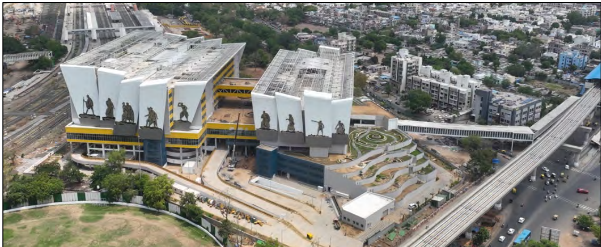
गुजरात के साबरमती पैसेंजर टर्मिनल हब में फिनिशिंग का काम चल रहा है
