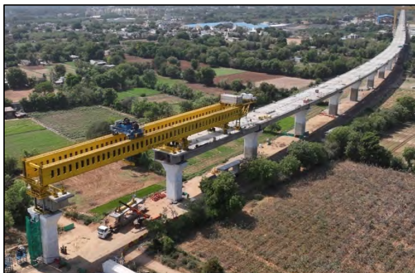
सेगमेंटल लॉन्चिंग प्रगति पर, वडोदरा, गुजरात
