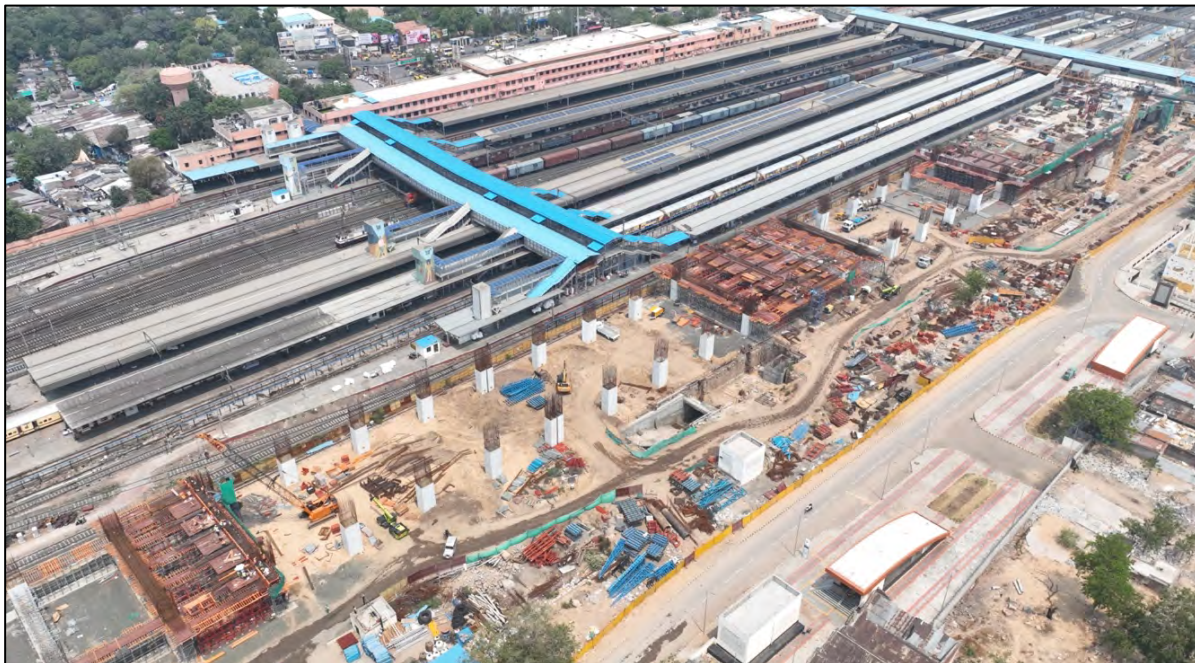
गुजरात के अहमदाबाद एचएसआर स्टेशन पर कार्य प्रगति पर
