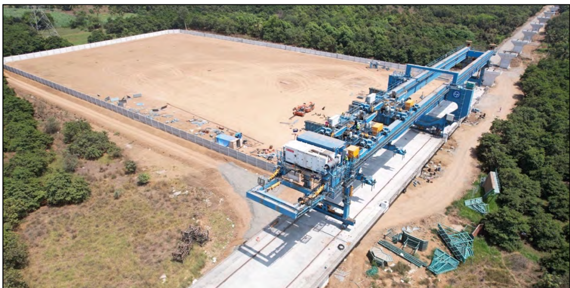
फुल स्पैन गर्डर लॉन्चिंग का काम प्रगति पर, नवसारी, गुजरात
