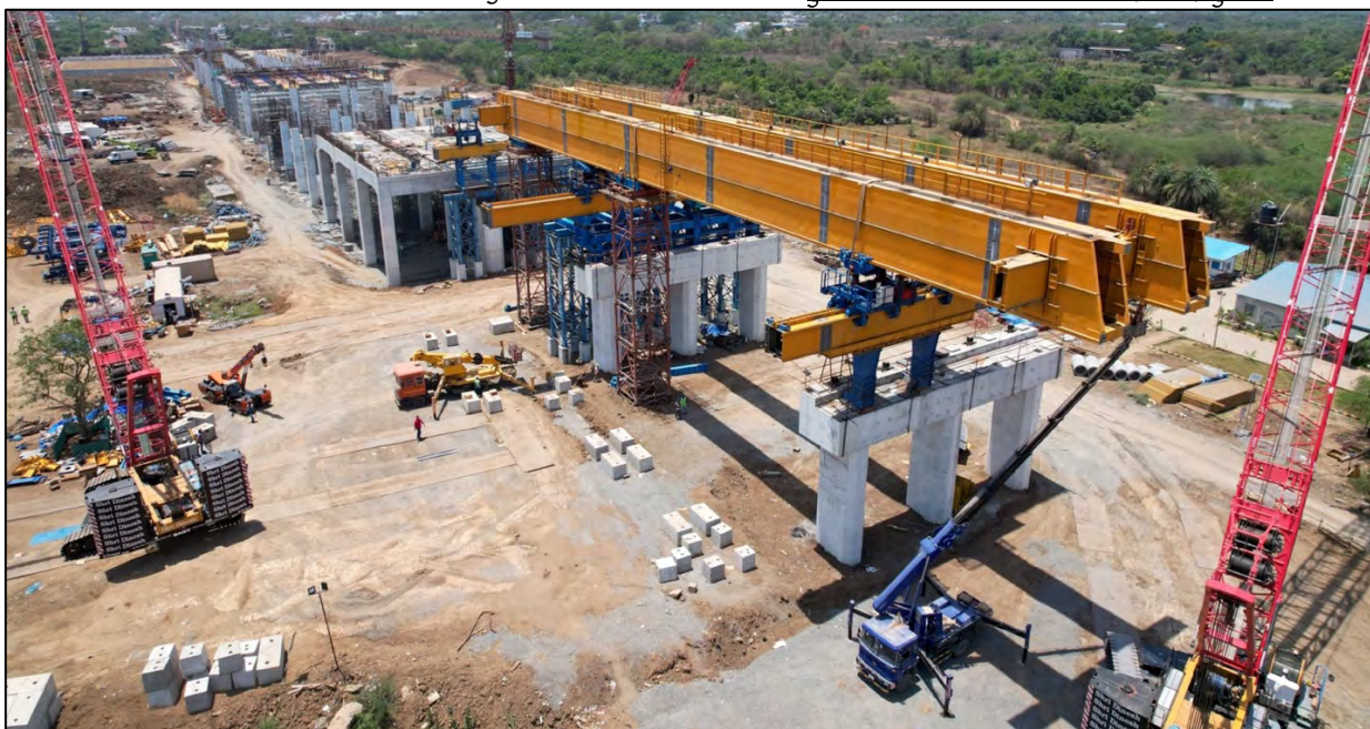
एचएसआर बिलिमोरा स्टेशन एप्रोच वायाडक्ट लॉन्चिंग प्रगति पर है।
