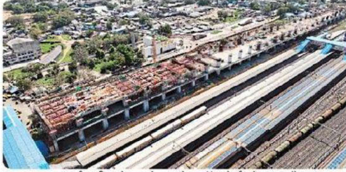
अहमदाबाद हाई स्पीड रेल स्टेशन के कॉनकोर्स लेवल स्लैब का निर्माण हुआ पूरा। - पत्रिका
